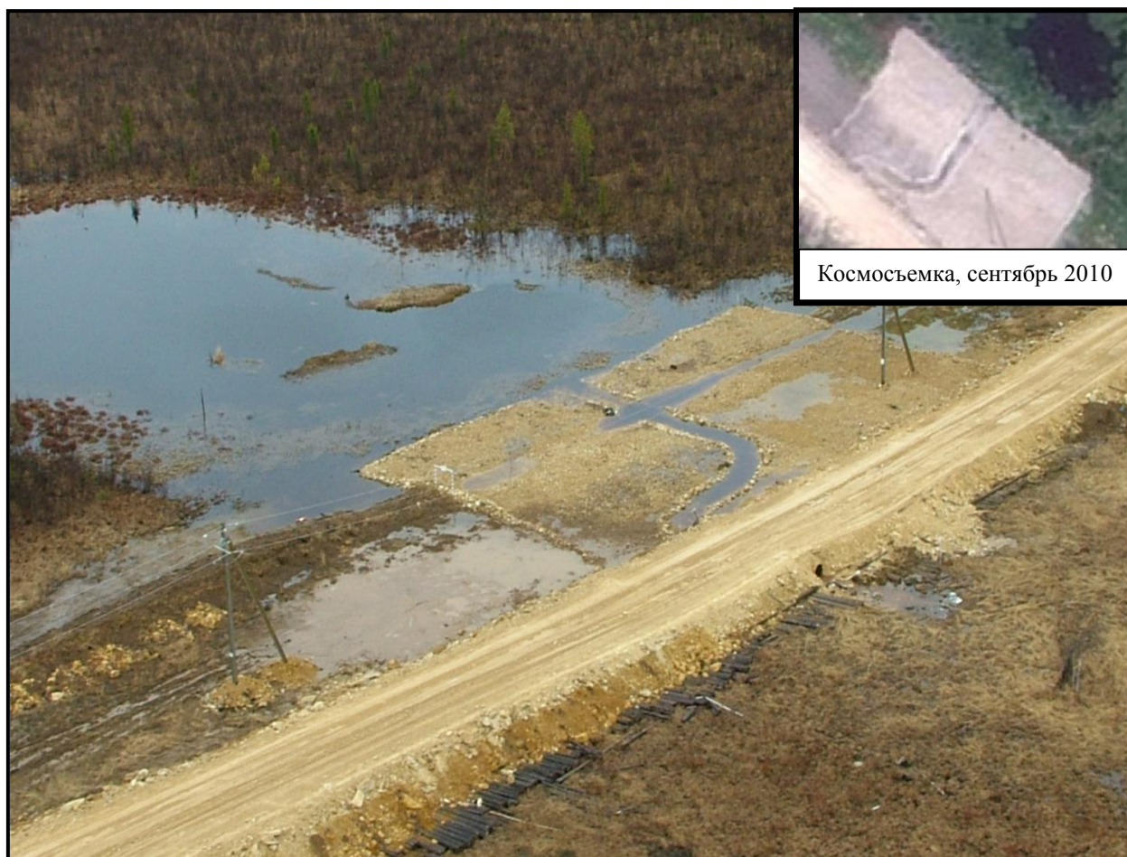
Рисунок 3.4.1 - Неэффективные мероприятия по восстановлению естественного стока на участке Ленск-Олёкминск, май 2011 г. (развиваются вторичные термокарстовые просадки на гравийной отсыпке)
