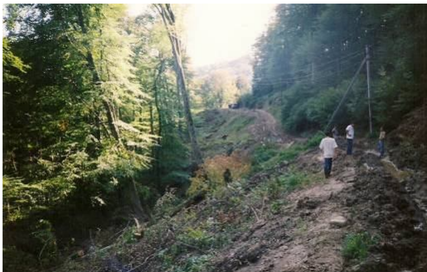
Рис. 2. Оползень пластического течения (газопровод высокого давления «Адлер – Красная Поляна»)
