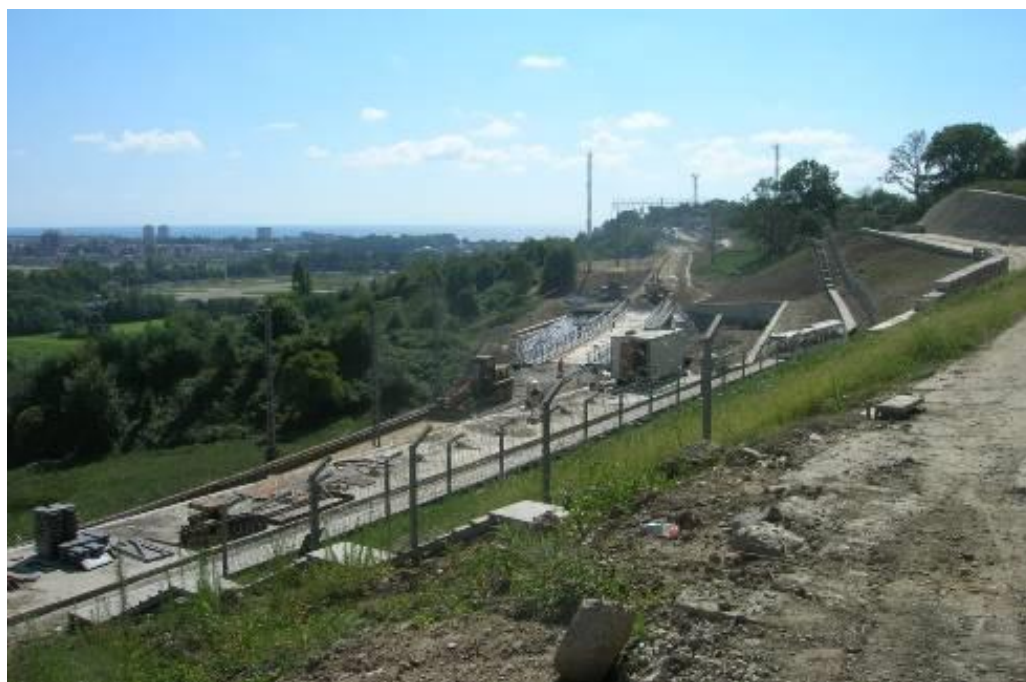
Рисунок 5.7 – Площадка строительства железной дороги Адлер – аэропорт
