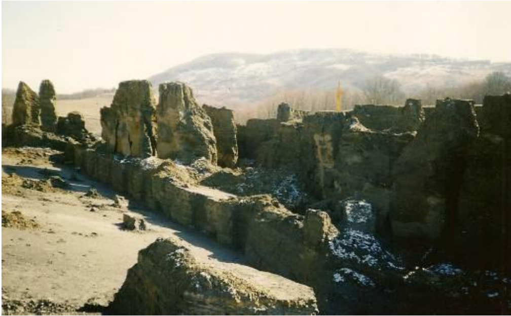
Рисунок 2.5 – Оползень скольжения консеквентный (автомобильная дорога Обход г. Сочи, ПК52)
