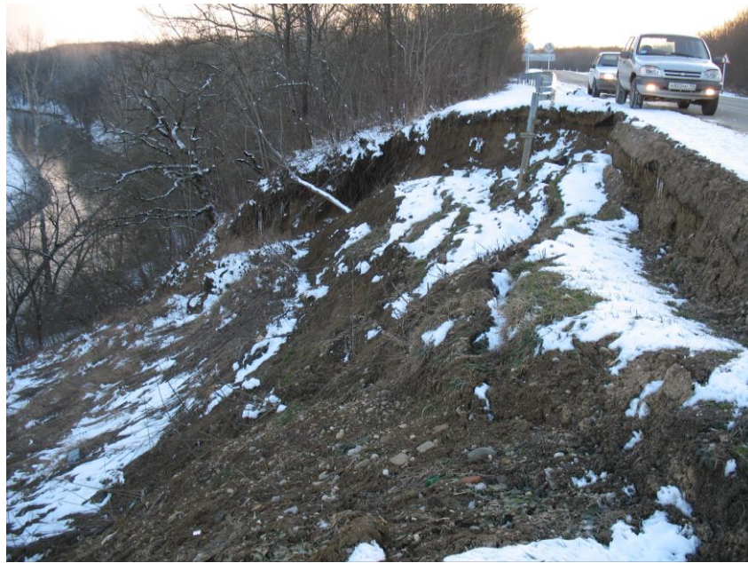
Рисунок 3.9 – Смещения насыпных грунтов низового откоса автомобильной дороги в результате повышенных динамических нагрузок и боковой эрозии реки
