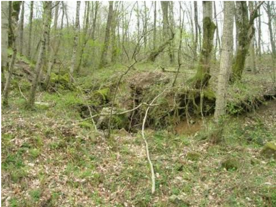
Рисунок 5.5 – Стенки срыва грунта на низовом склоне ТПТС Макопсе – Наджиго, км 5+300
