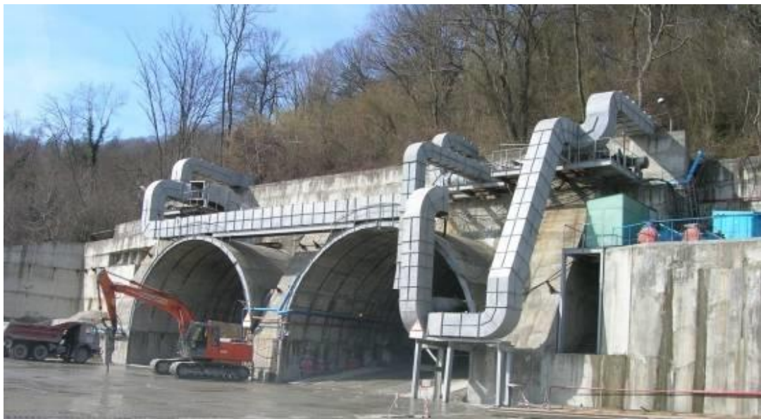
Рисунок 2.9 – Площадка строительства на оползневом склоне южного портала тоннеля № 6 автомобильной дороги М-27 Джубга – Сочи
