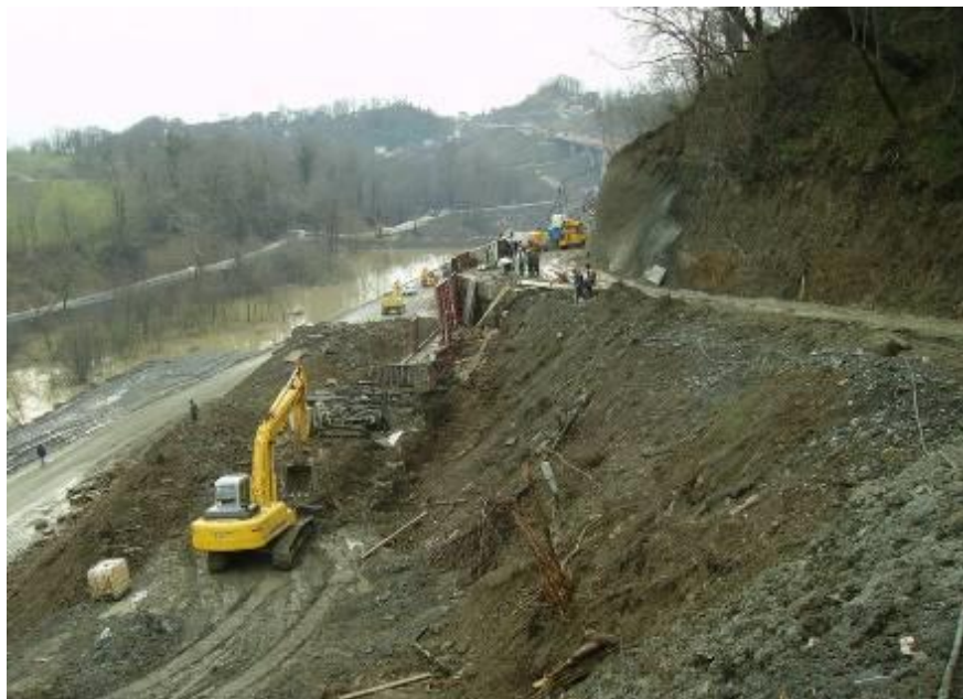
Рисунок 3.10 – Строительные работы на низовом откосе автомобильной дороги в стесненных условиях
