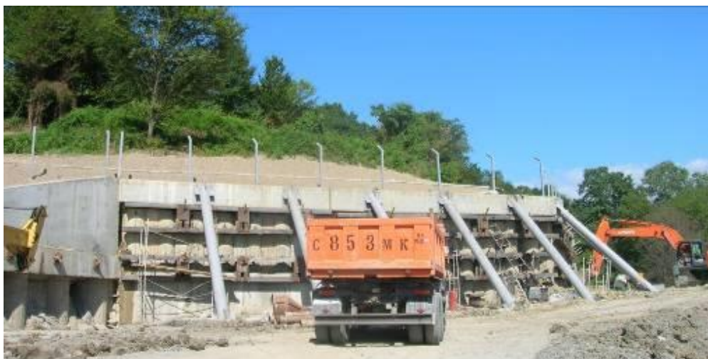
Рисунок 5.8 – Строительство удерживающего сооружения на площадке ВОХР у западного портала железнодорожного тоннеля № 2
