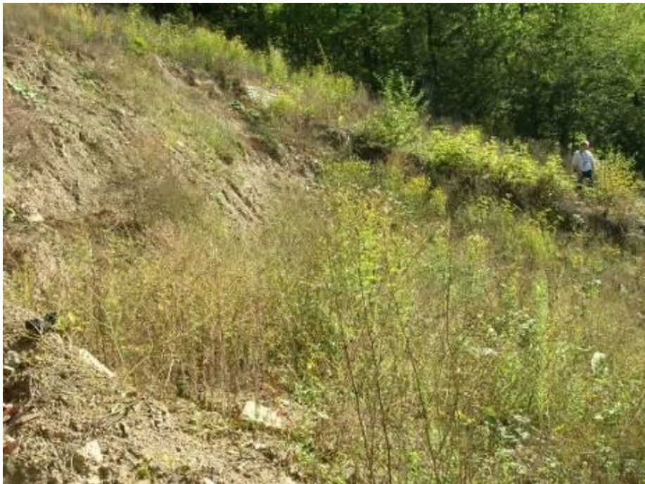
Рисунок 5.18 – Оползень на участке ПК287–ПК288 трассы газопровода «Россия – Турция»
