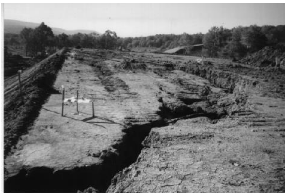
Рисунок 2.16 – Смещение грунта на Восточном откосе площадки установки подготовки газа к транспорту компрессорной станции «Краснодарская» газопровода «Россия – Турция» (2001 г.)
