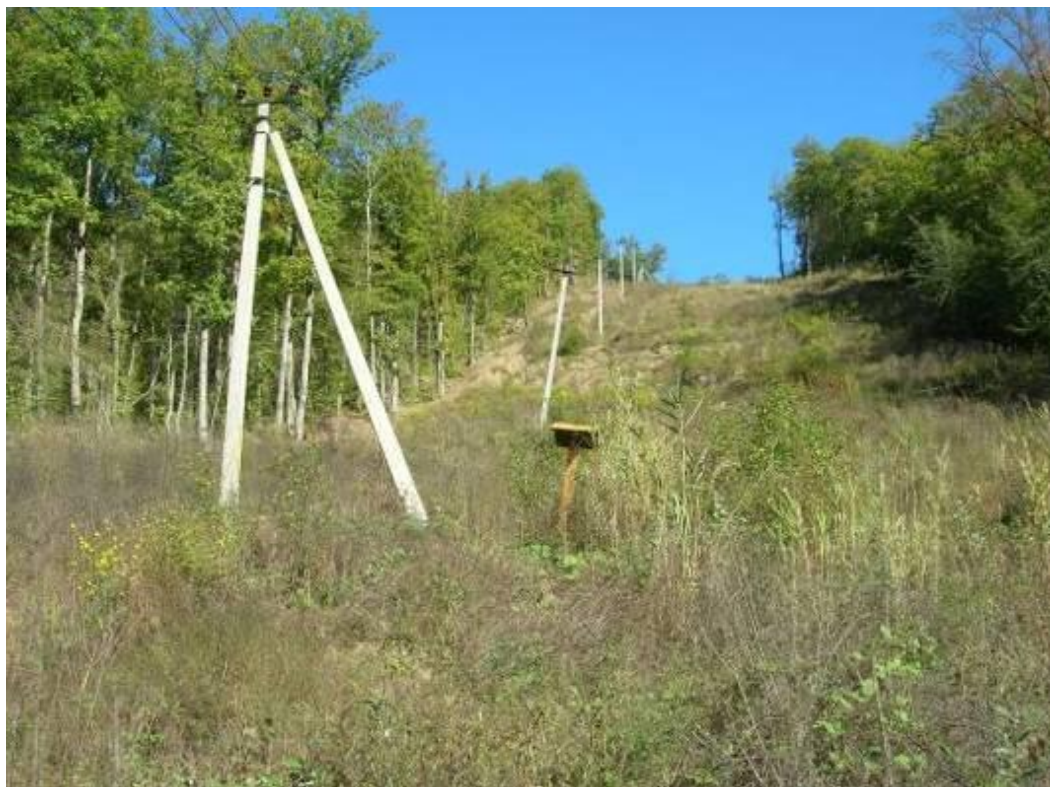
Рисунок 5.15 – Оползневой склон в районе расположения опор №4742–4747, ПК287–ПК288 вдольтрассовой ВЛ газопровода «Россия–Турция»
