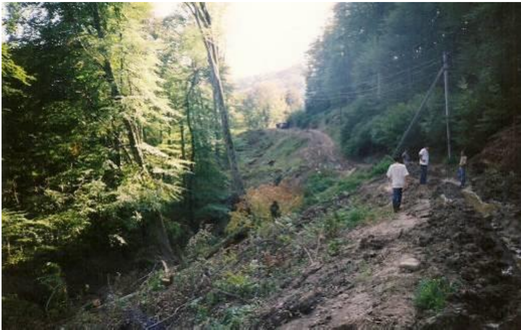
Рисунок 2.6 – Оползень пластического течения (газопровод высокого давления «Адлер – Красная Поляна»)
