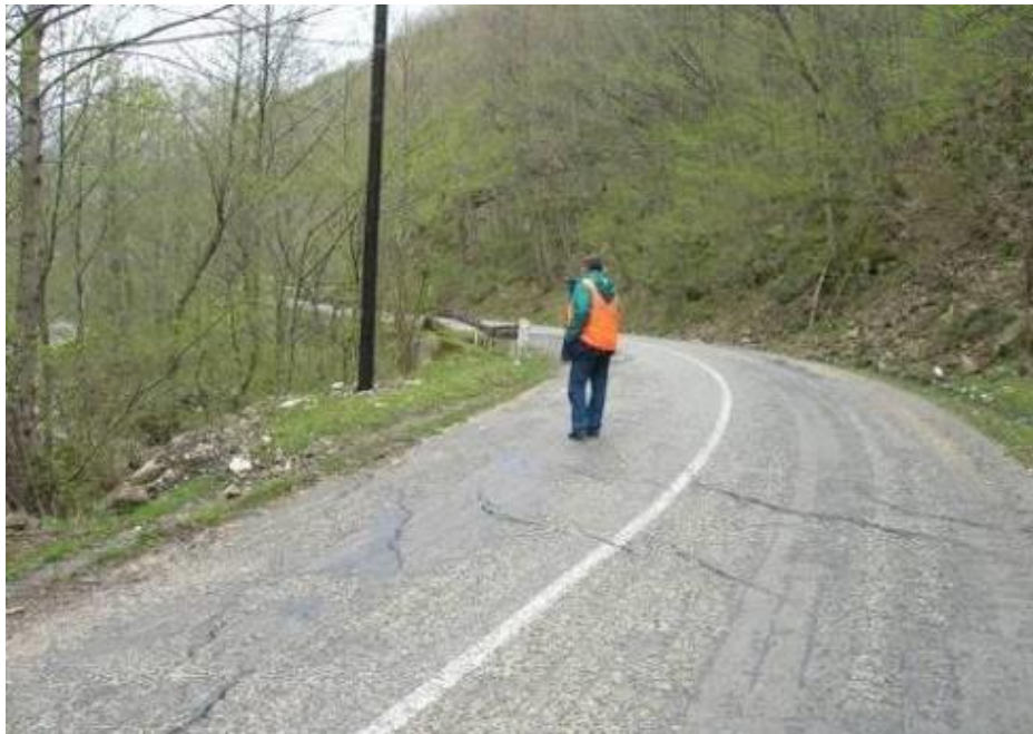
Рисунок 5.1 – Общий вид на автодорожную ТПТС Макопсе – Наджиги (км 5+300)
