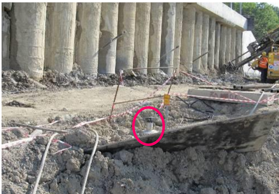
Рисунок 5.11 – Инклинометрическая скважина на участке строительства удерживающего сооружения на площадке ВОХР [184]
