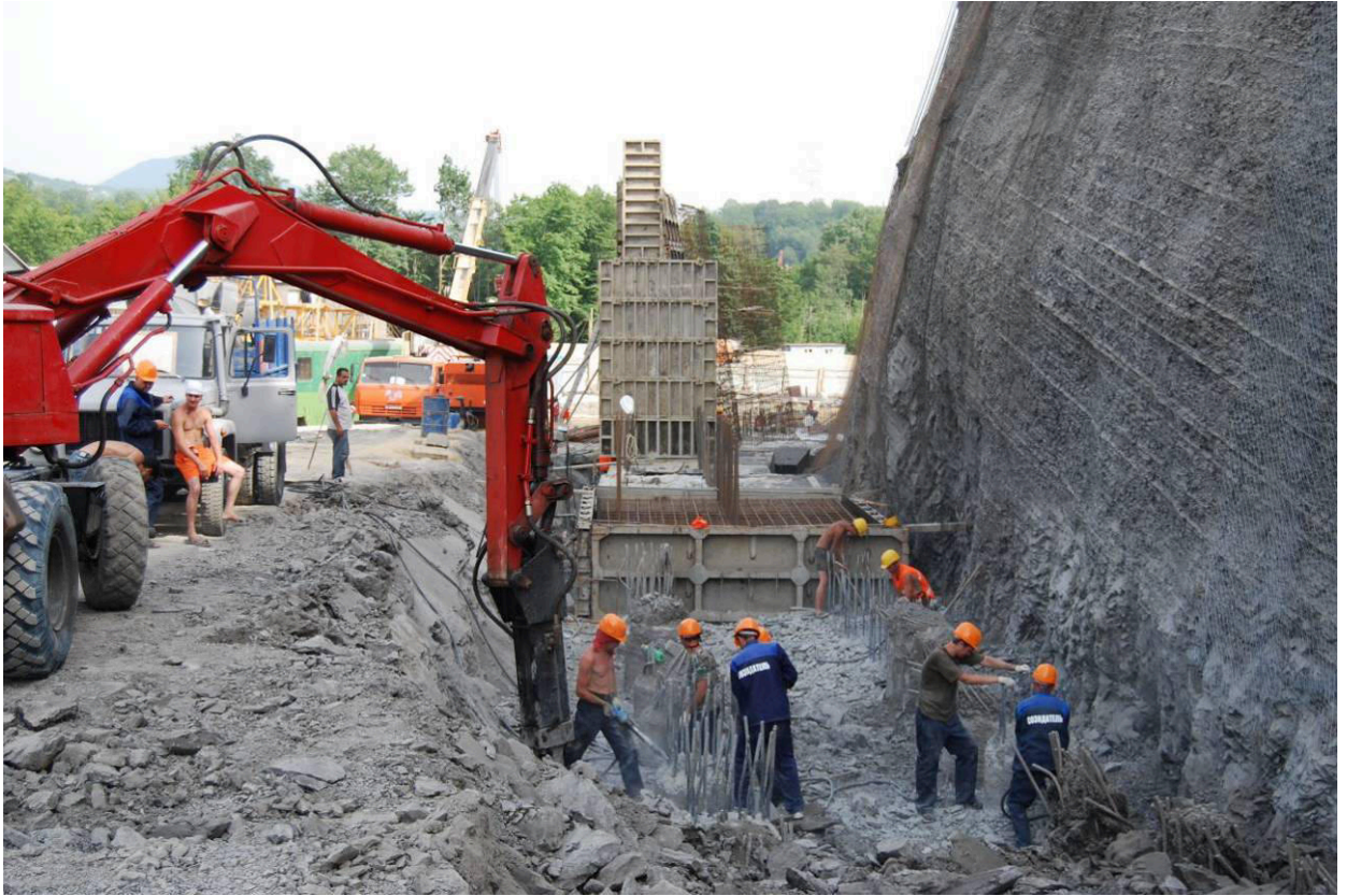
Рис. 63. Строительство подпорной стены у основания подрезанного склона.
