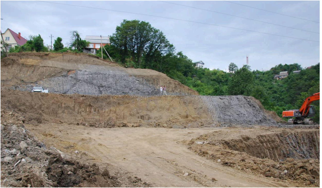
Рис. 53. Три верхние ступени террасируемого склона Транспортной развязки.
