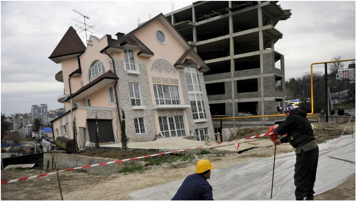
Рис. 60. Дома, пострадавшие в результате аварии в тоннеле 8а 3 марта 2013 года.
