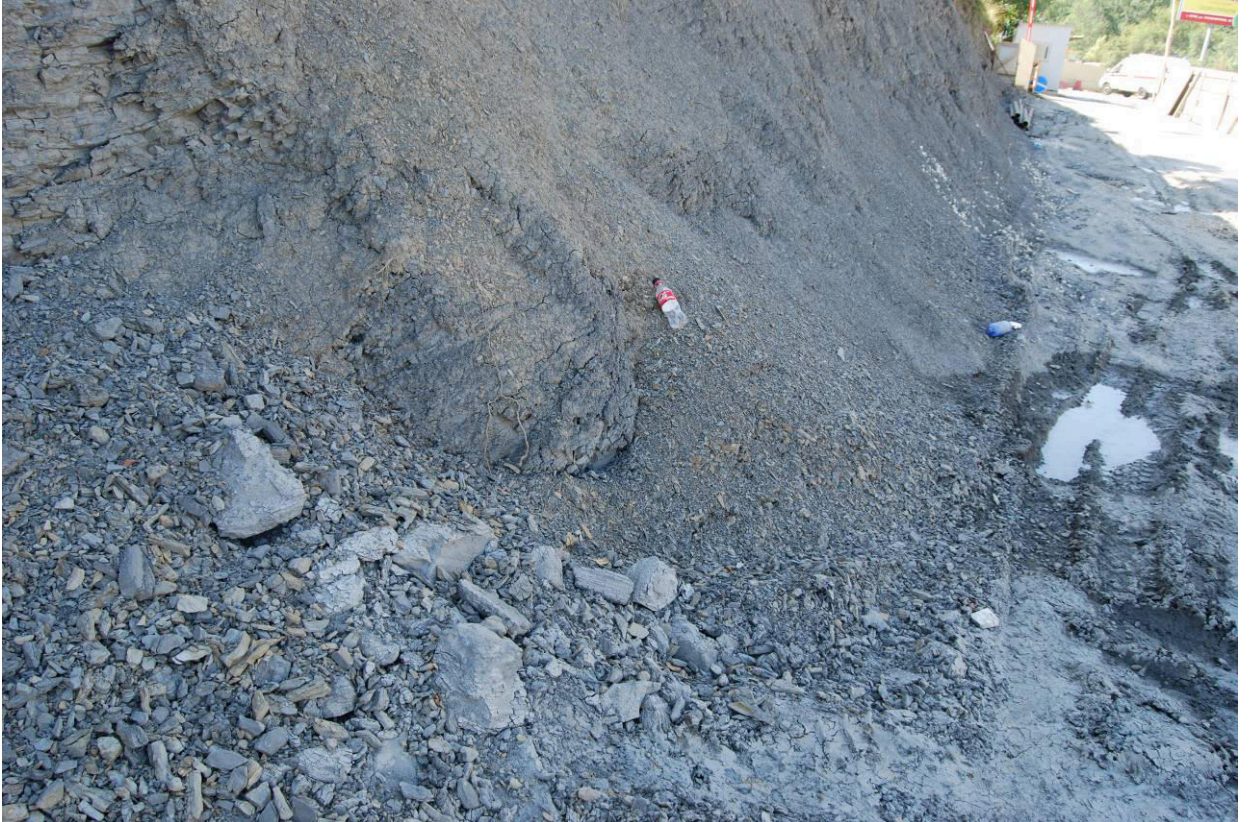
Рис. 45. Склон аргиллитоподобных глин спустя 5 дней после подрезки.
