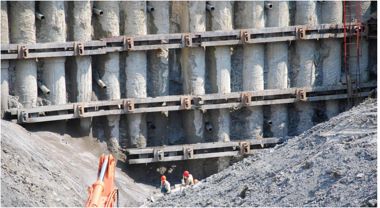
Рис. 58. Промежуточный доступ к тоннелям 8 и 8а. Устройство водоотведения в подпорных сооружениях из шпунтового ряда свай.
