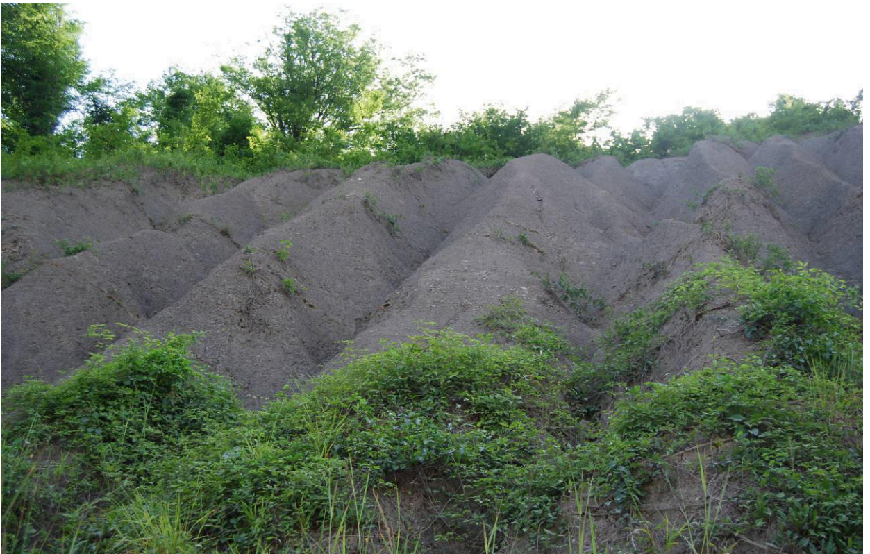
Рис. 46. Неукрепленный после подрезки склон аргиллитоподобных глин.
