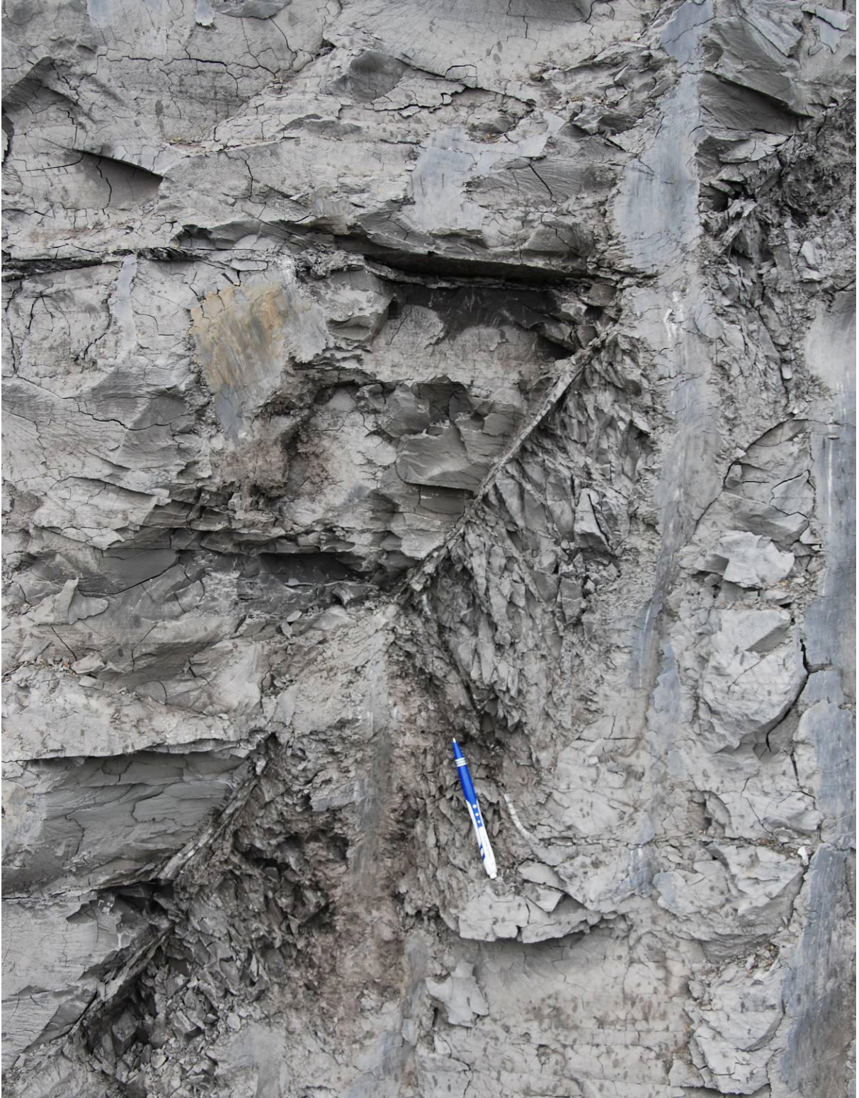
Рис. 10. Массив аргиллитоподобных глин. Тектонические смещения, открытые трещины и трещины, заполненные кальцитом.
