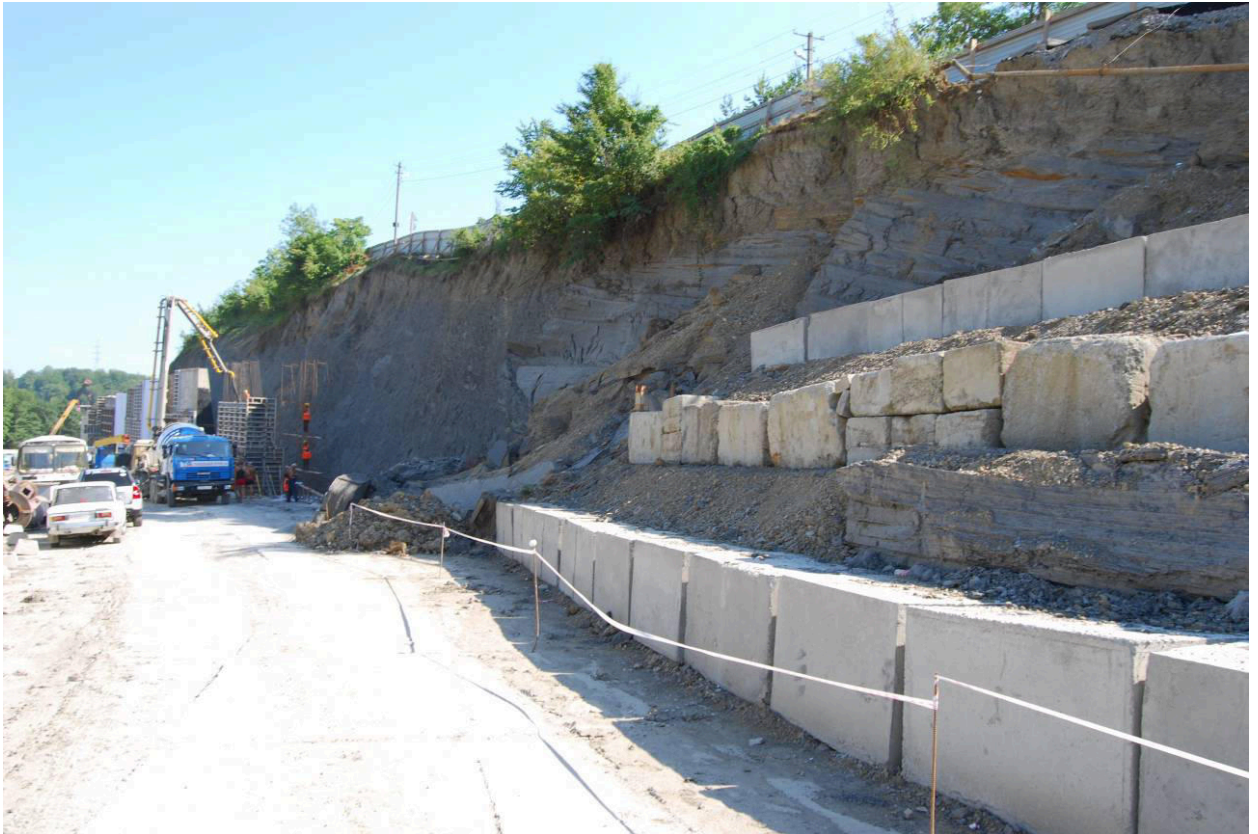
Рис. 62. Реконструкция автодороги по ул. Транспортная с расширением проезжей части и подрезкой прилегающих склонов.
