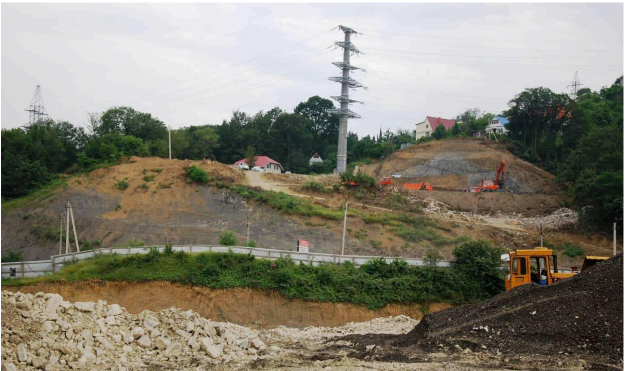
Рис. 54. Общий вид террасируемого склона.
