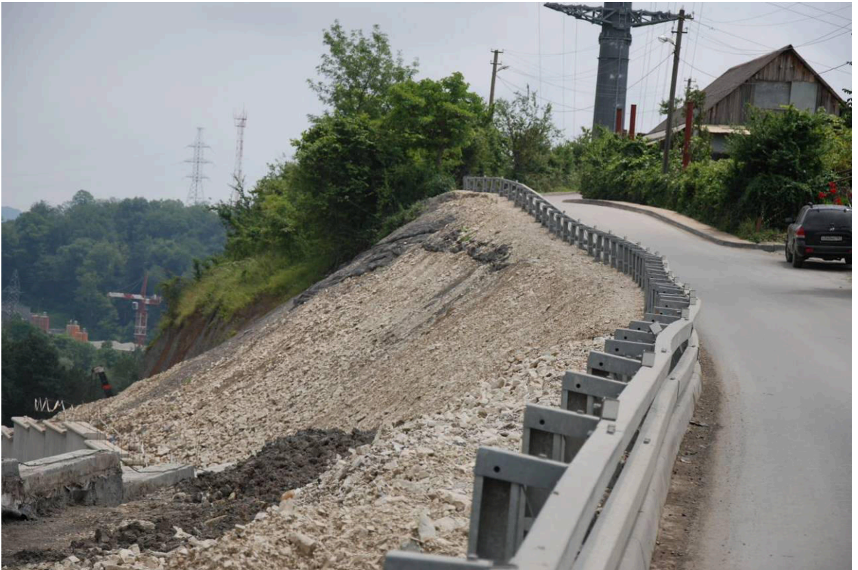
Рис. 65. Верхняя часть засыпки декоративно отсыпана слоем крупнообломочного материала.
