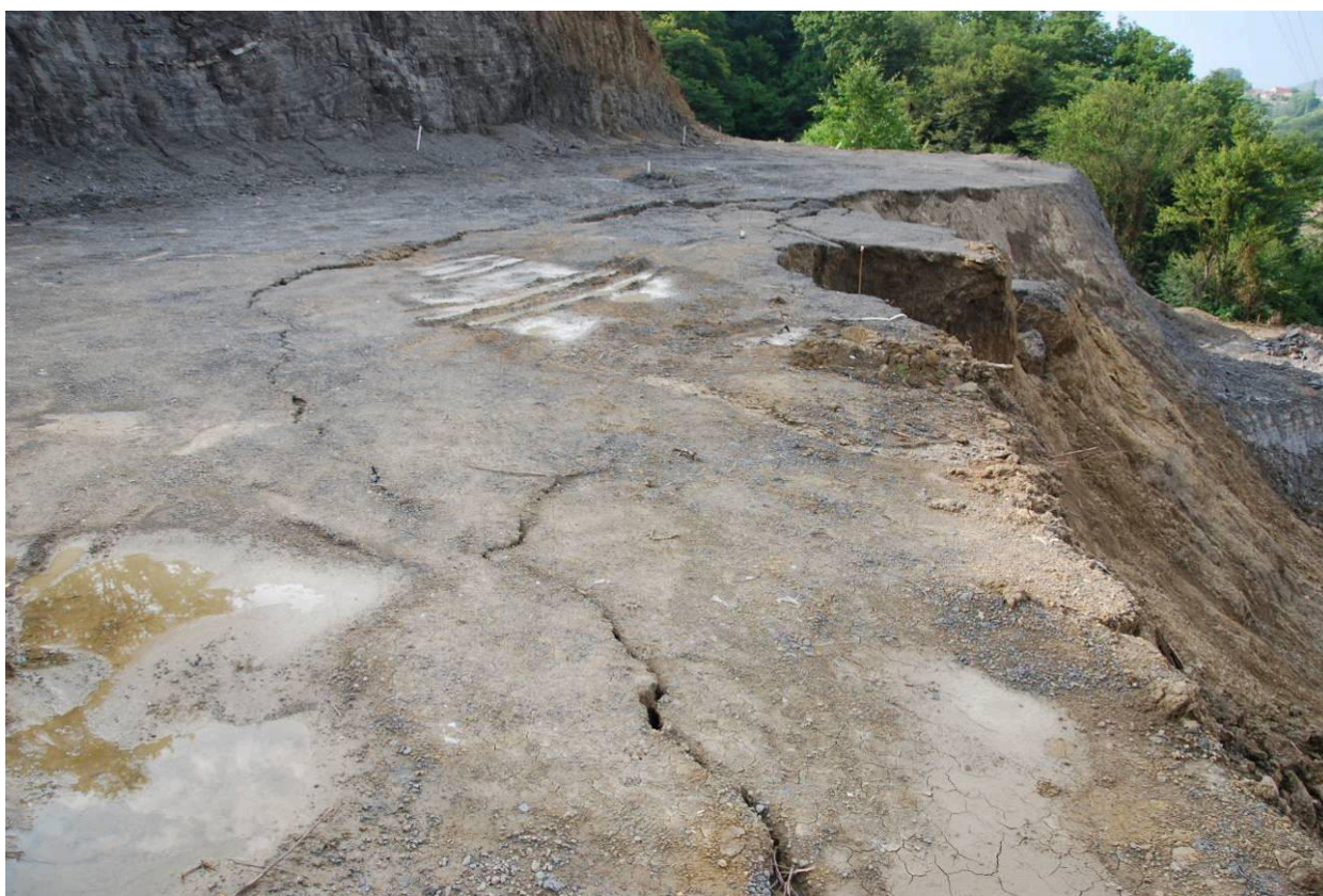
Рис. 56. Развитие оползневой структуры на подошве второй ступени подрезки склона.
