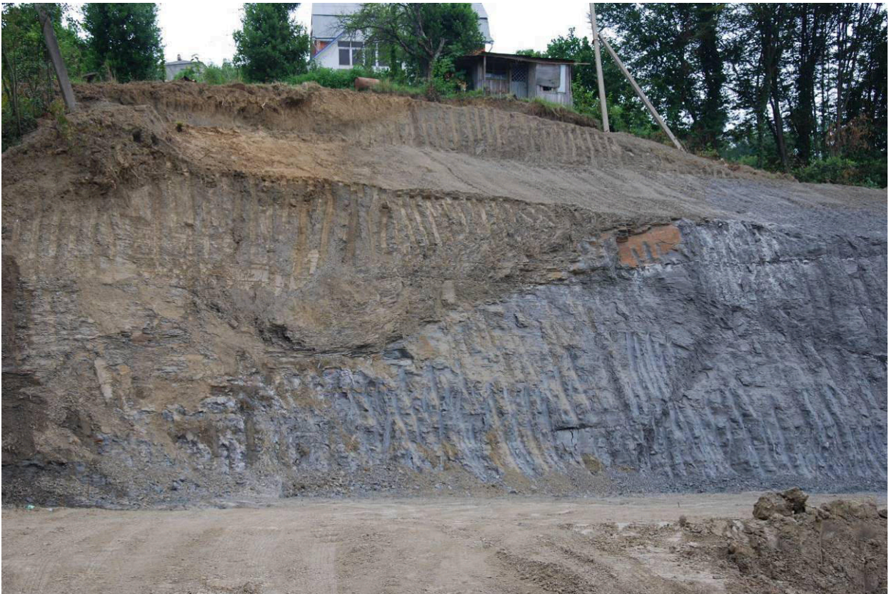
Рис. 52. Вторая ступень террасируемого склона Транспортной развязки.
