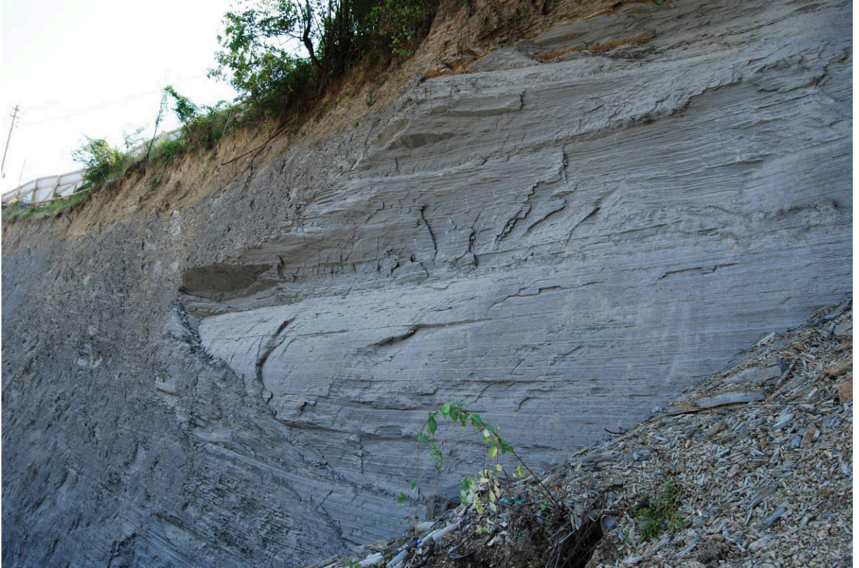
Рис. 47. Поверхность скола после крупного вывала по секущей слою трещине на подрезанном склоне аргиллитоподобных глин.
