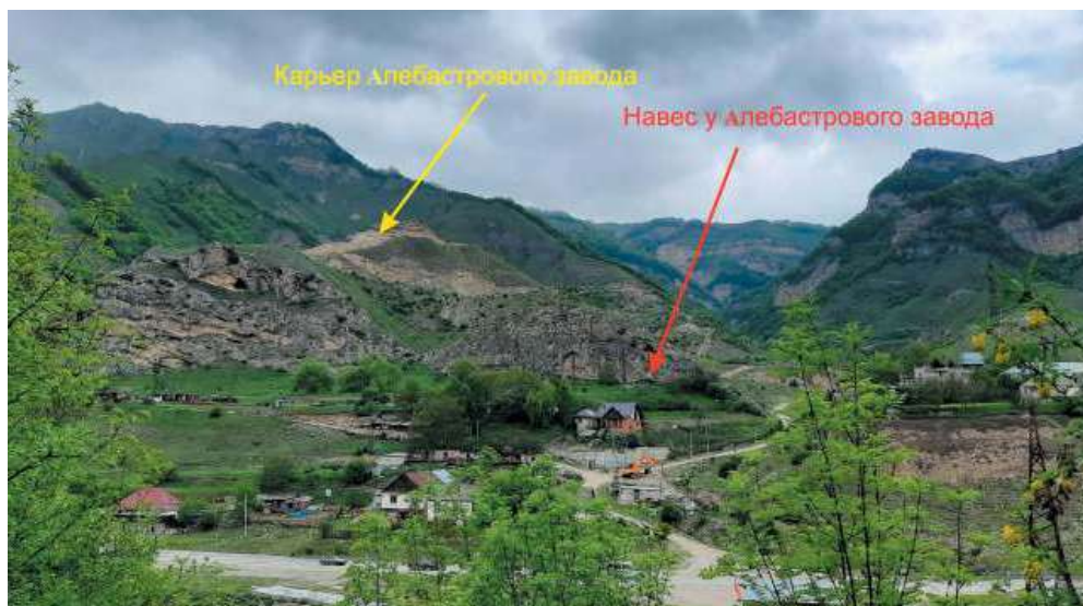
Рисунок 18. Общий вид на навес у Алебастрового завода и отвалы алебастрового карьера с правобережья р. Баксан.
