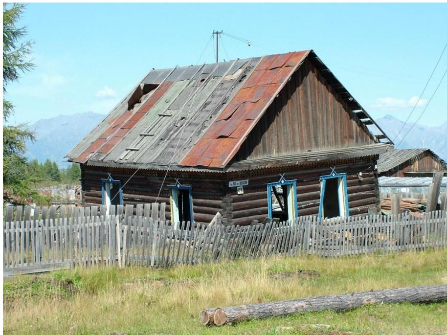
Рисунок 1.16 Неравномерная осадка основания сельского дома (Северное Забайкалье).
