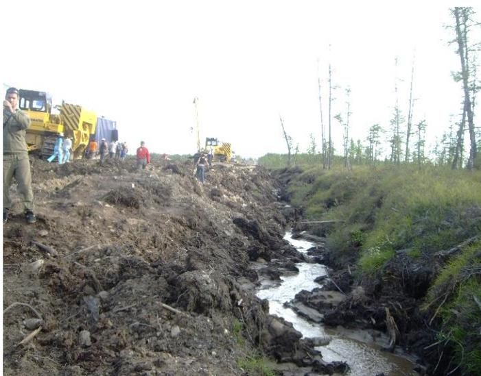
Рисунок 1.6 Термоэрозионный овраг, развивающийся вдоль временной дороги (Восточная Сибирь).
