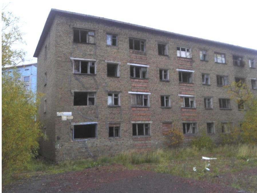
Рисунок 4.9 Разрушение жилого дома в г. Воркуте в результате неравномерной осадки угловой части фундамента (фото 2016 г.).
