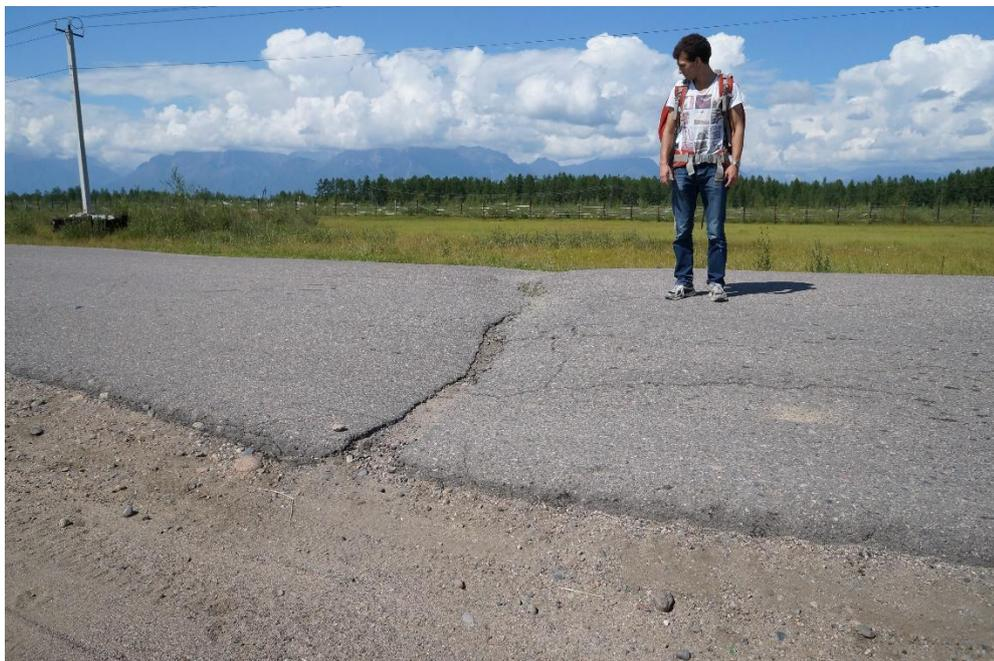
Рисунок 1.18 Морозобойные трещины на покрытии автомобильной дороги (Северное Забайкалье).
