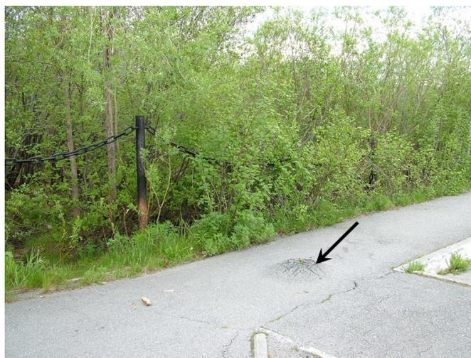
Рисунок 1.14 Морозное пучение выталкивает старую деревянную сваю, расположенную под асфальтовым покрытием (Лабытнанги, Западная Сибирь).
