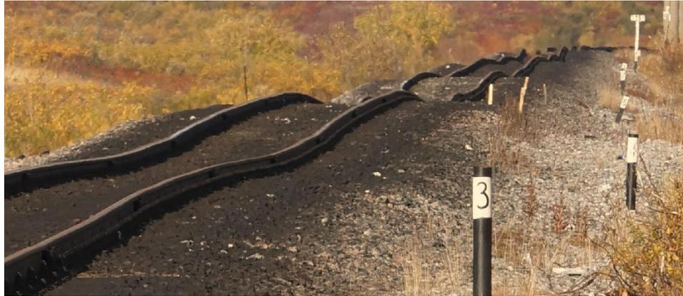
Рисунок 4.10 Профильные просадки насыпи, возникающие при прогрессирующем оттаивании основания и/или при пластических деформациях оттаявшего слоя грунта (Северная железная дорога близ станции Хановой, 2015 г.).
