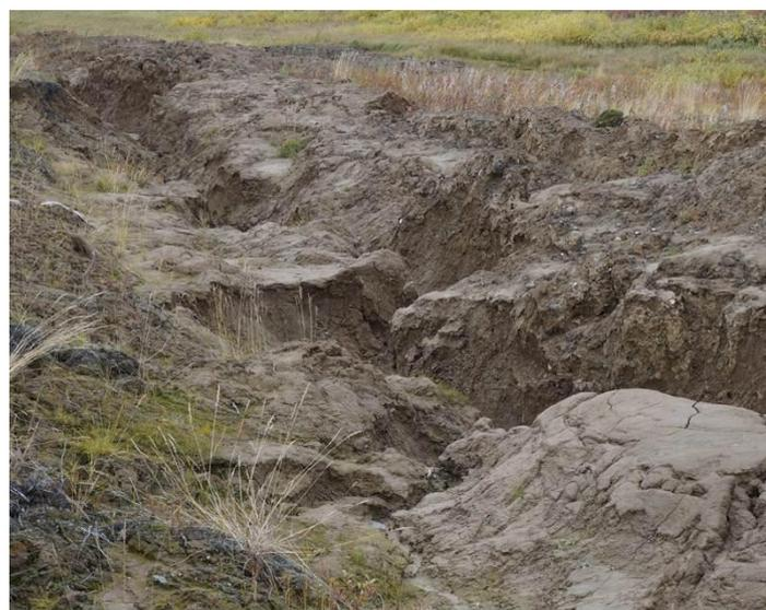
Рисунок 1.7 Термоэрозионная промоина вдоль трубопровода (Большеземельская тундра, Европейский Север России).
