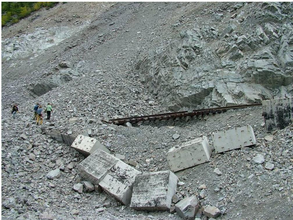
Рисунок 1.25 Конус выноса снежно-каменной лавины, разрушившей плотно железной дороги (Северное Забайкалье).
