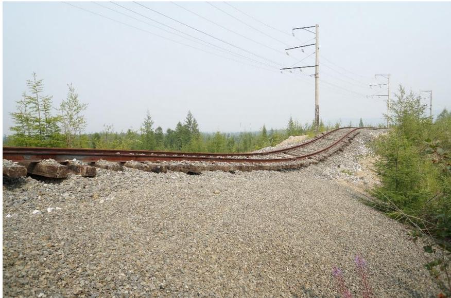
Рисунок 1.17 Результирующая осадка насыпи неиспользуемой железной дороги Чара-Чина, развивавшаяся в течение 13 лет (Северное Забайкалье, Восточная Сибирь).
