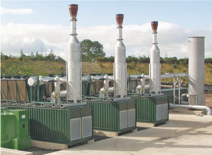
Рис. 2.5.2. Система удаления и утилизации биогаза из тела мусорной свалки
