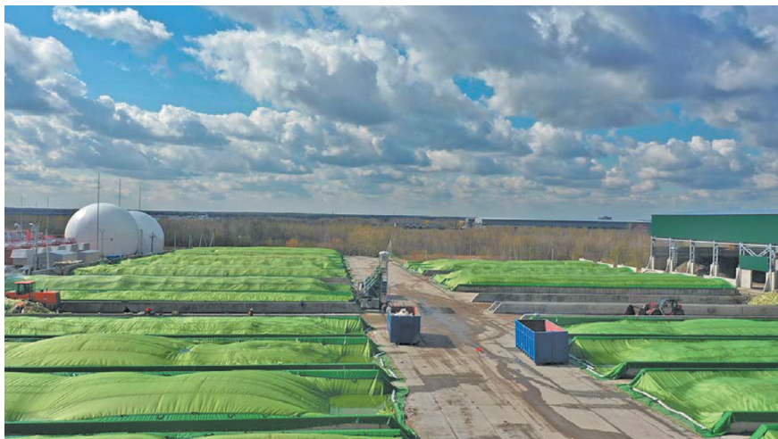
Рис. 1.2.1. Технология мембранного компостирования отсева ТКО после сортировки (Источник: URL: https://ntc-tbo.ru/catalog/kompost/ )
